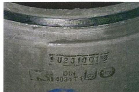
Betonschacht DN 1000 nach DIN EN 1917 / DIN 4034 Typ 2 mit elastomeren Dichtungen, zugelassen für Schmutz- und Mischwasser
